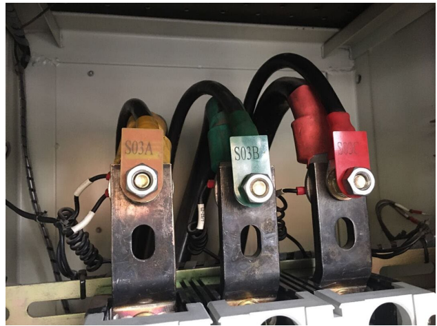
Bild 6 flache RFID-Sensoren mit Kabelverschraubung montiert
