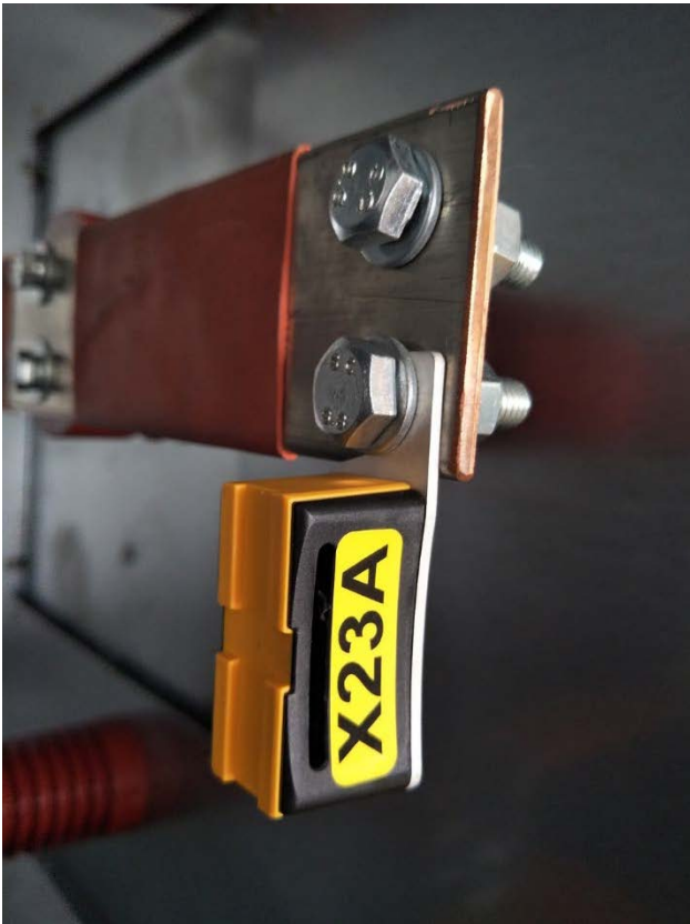
Bild 4 RFID-Sensoren an eine Stromschiene geschraubt
