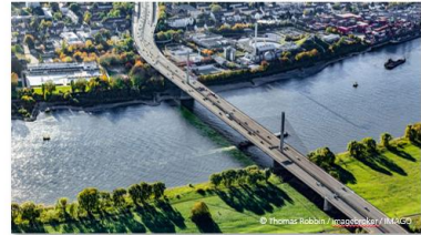
Bonn: Vollsperrung der Rheinbrücke Bonn-Nord (Friedrich-Ebert-Brücke) seit 03.06.2026 wegen strukturellen Schäden am Tragwerk der linksrheinischen Vorlandbrücke.
